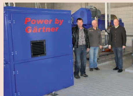
50 KW Gasaggregat erzeugt Strom für die Kläranlage in Zellhof.
